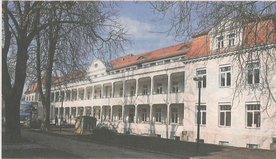
Das denkmalgeschützte Bettenhaus 10 im Klinikum St. Georg ist saniert und innen umgebaut worden und dient jetzt als Zentrum für Altersmedizin. Foto: André Kempner
