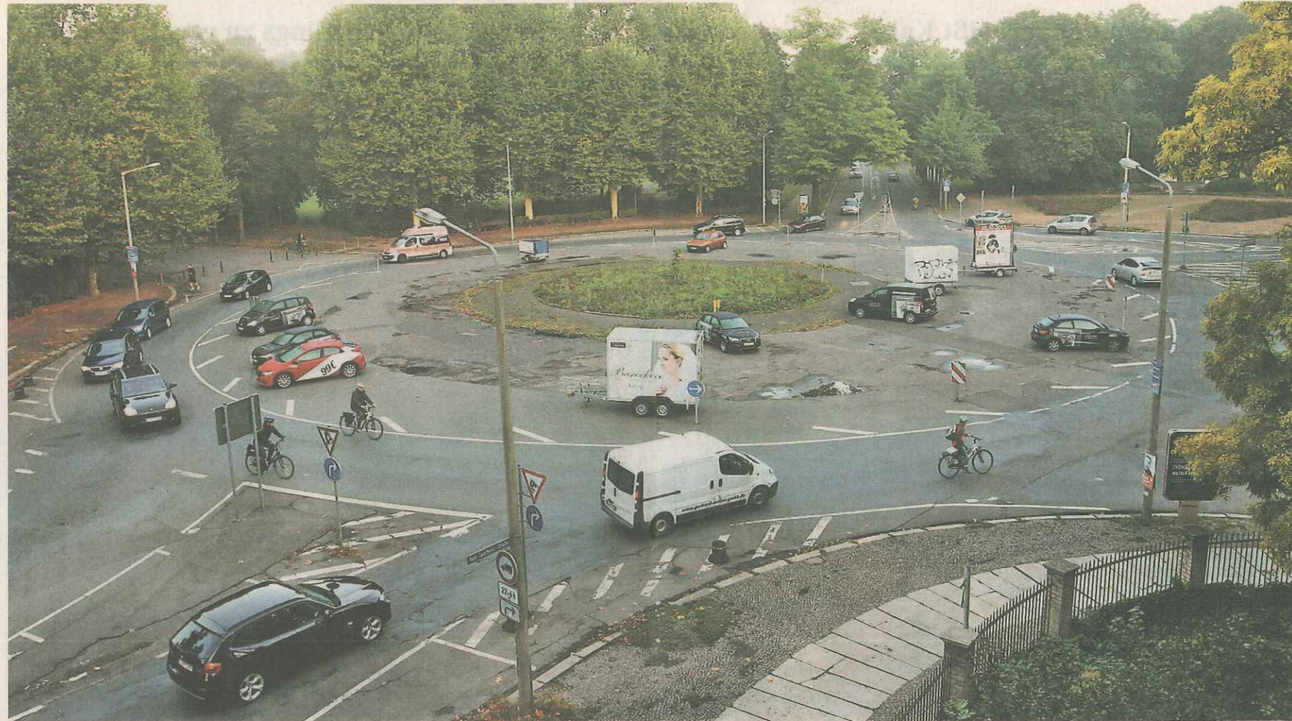
Der Kreisverkehr wird größer: Künftig wird es eine Innen- und eine Außenspur geben, die jeweils 3,50 Meter breit und durch eine weiße Linie getrennt sind. Sie können von Lastern überfahren werden. Die Stellplätze auf der Innenfläche gehen verloren. Am Rand des Platzes wird eine zweite Baumreihe gepflanzt. Foto: André Kempner
